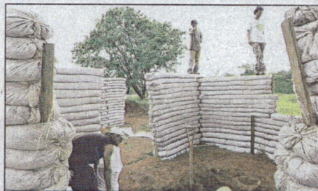
A técnica de superadobe agride menos o ambiente e é 40% mais barata
